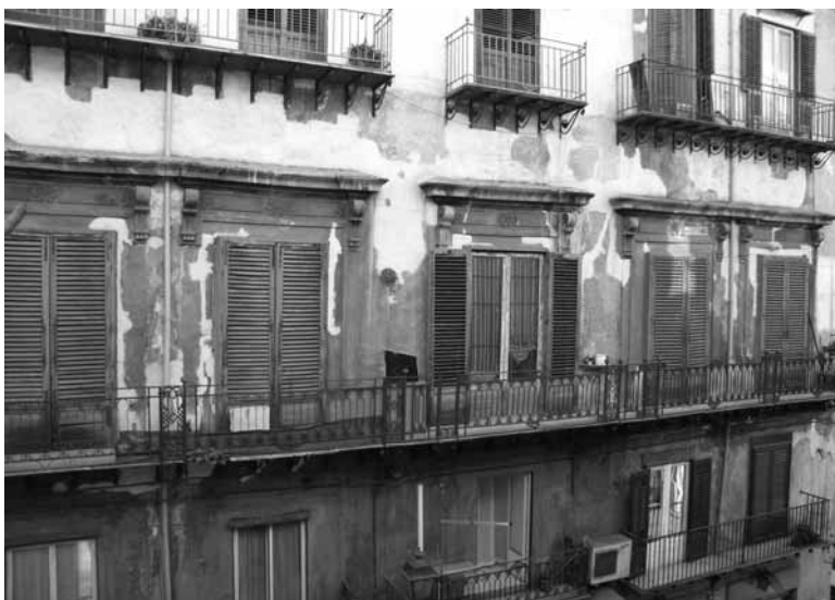
Fig. 3 - Il sistema delle finestre del piano nobile sul fronte principale.
